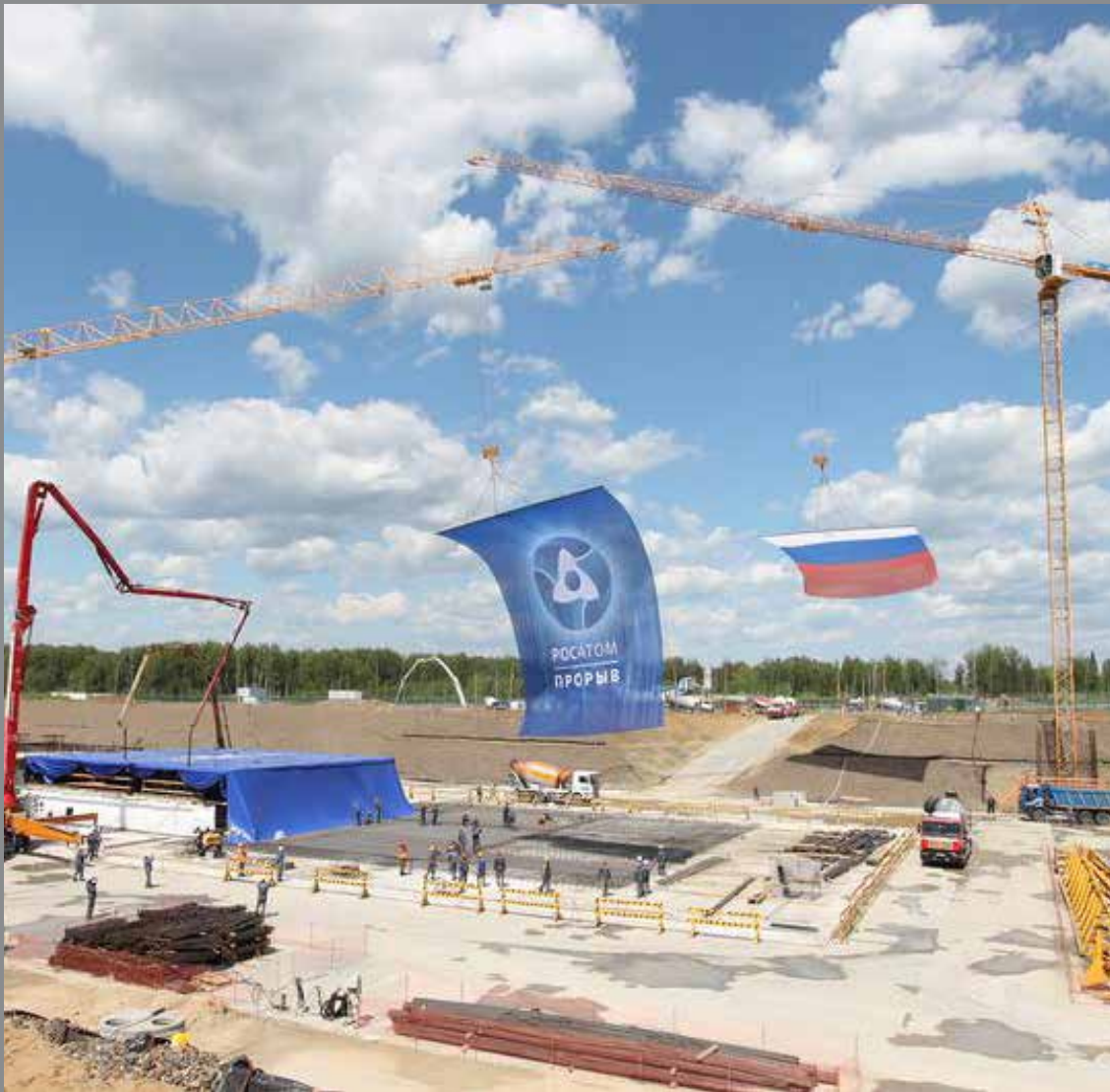
Церемония заливки первого бетона реактора БРЕСТ-ОД-300 Проекта Прорыв
