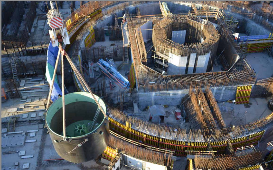
Установка ловушки расплава на строящейся Курской АЭС-2
