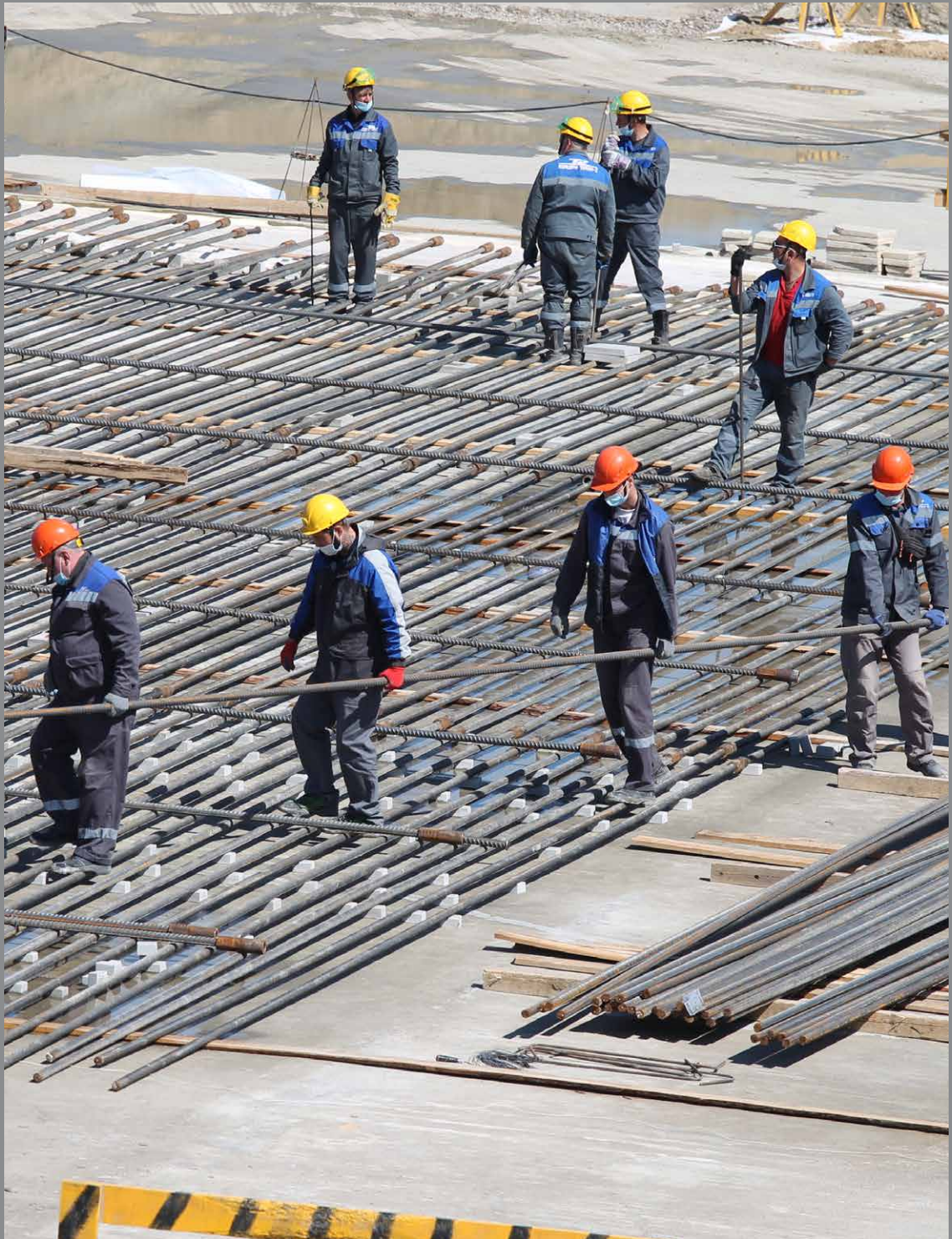
Заливка первого бетона реактора БРЕСТ-ОД-300 Проекта Прорыв
